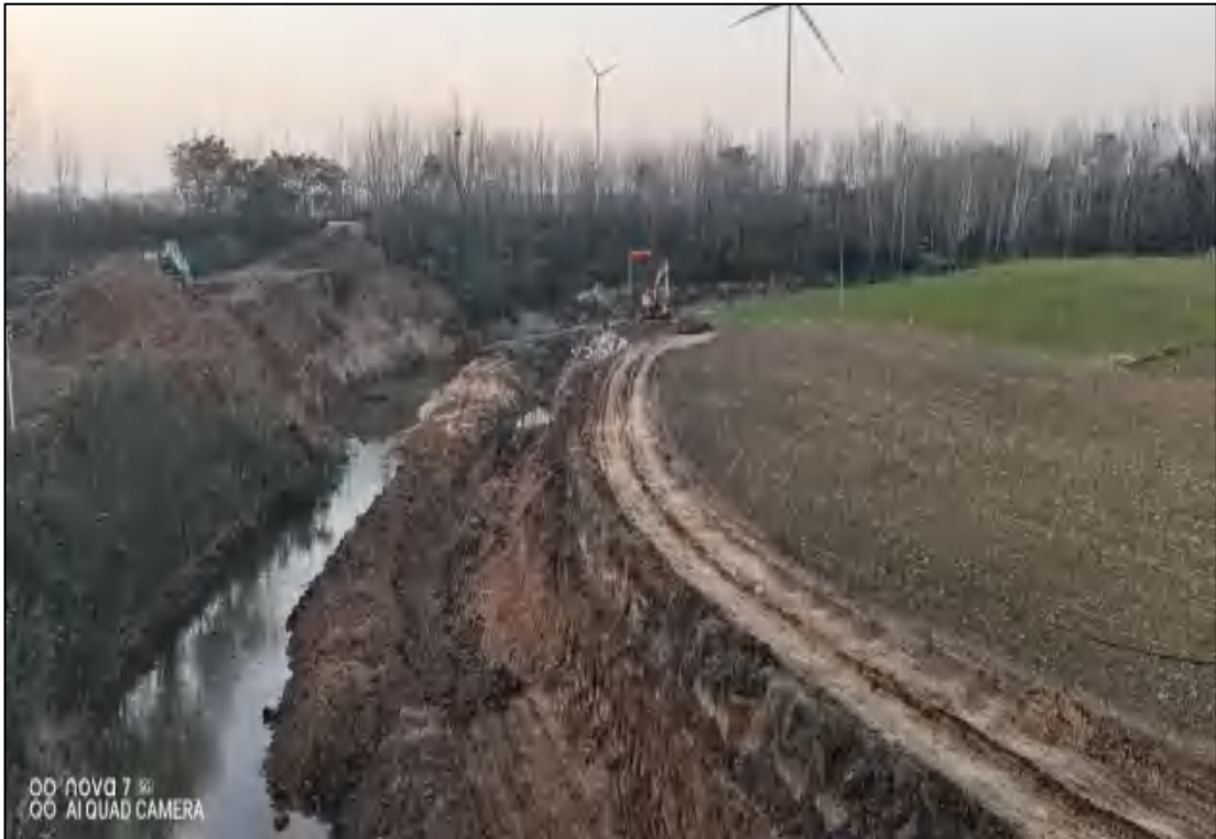
图 2.2-5 河道治理现场照片
