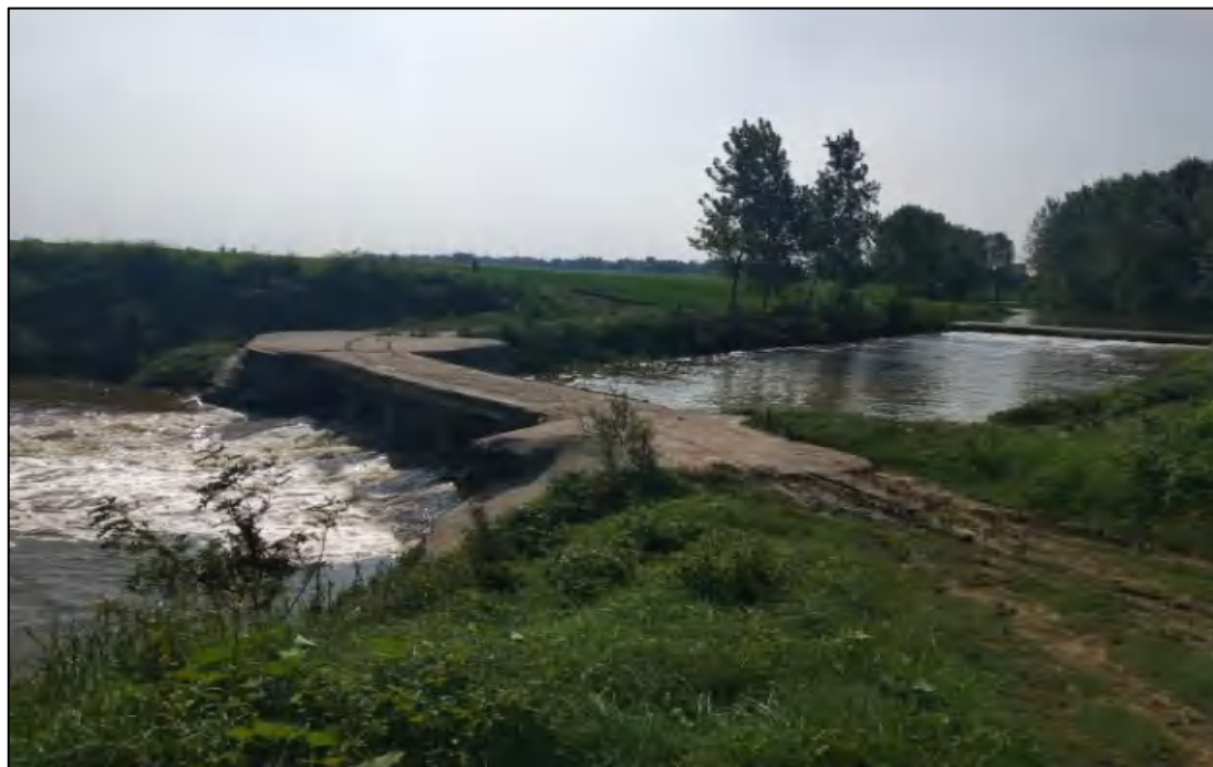
图 2.2-3 张家村平板桥照片
