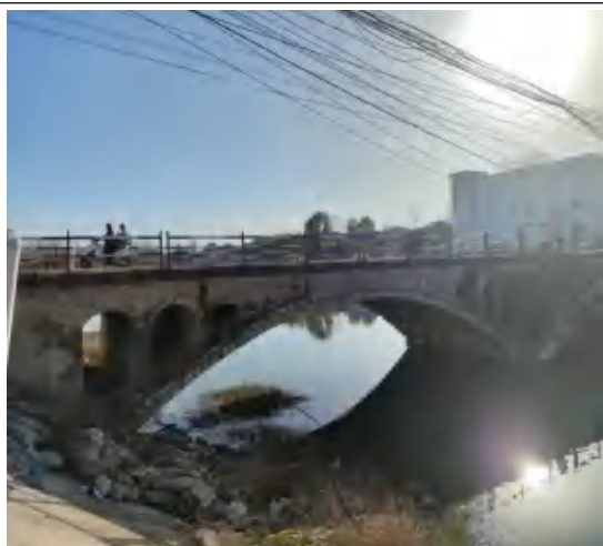
图 4.4-2 清水河祁仪镇区段桥梁图
