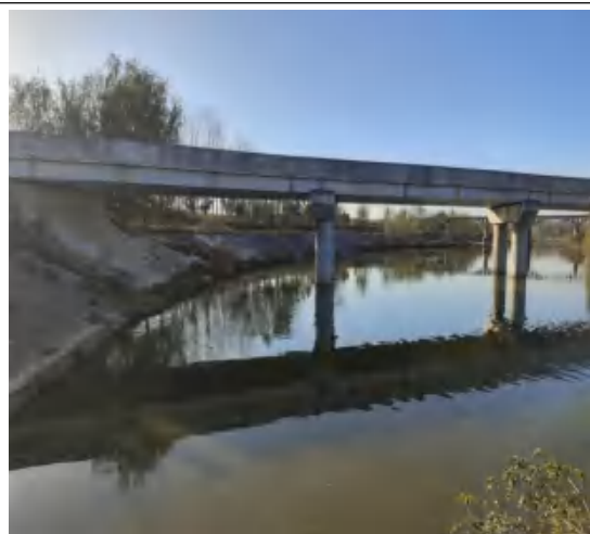
图 4.4-3 清水河窑上村段桥梁图
