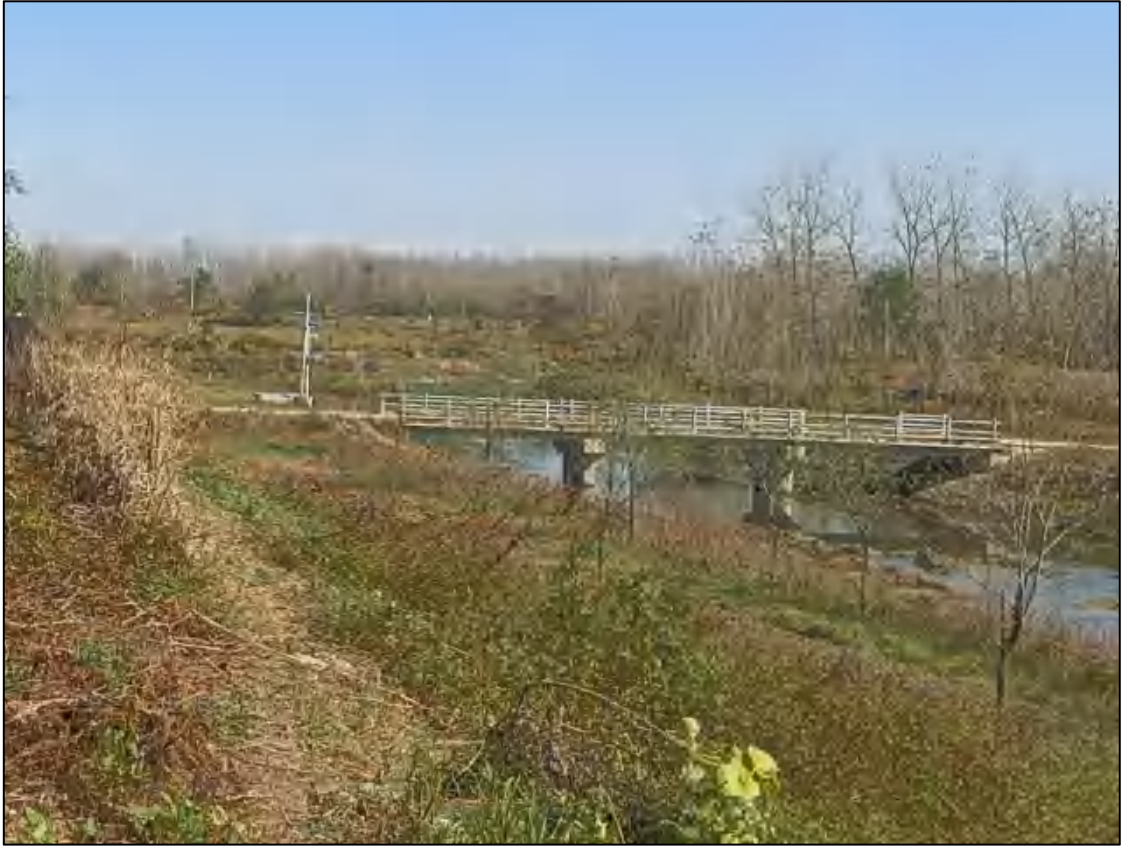
图 4.4-2 桐河镇区段桥梁
