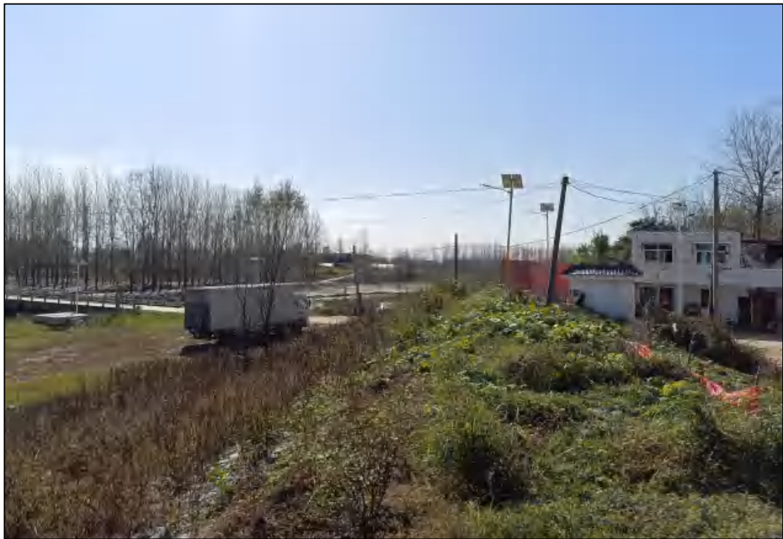
图 2.2-2 桐河右岸堤防
